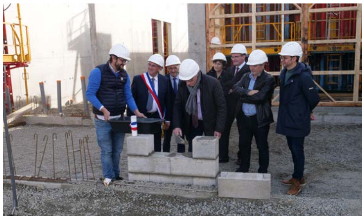
Pose de première pierre de la salle de motricité avec dojo
